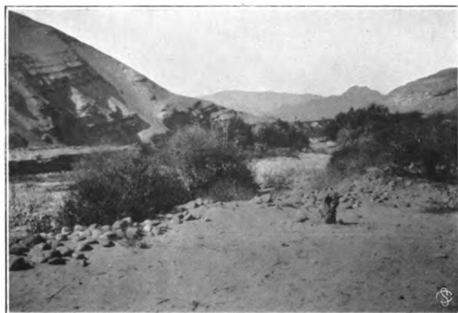
Fig. 14.—Vista general del puente Inga.
